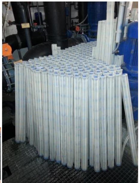
(Abb. li., die gereinigten Filterkerzen werden wieder eingesetzt)
